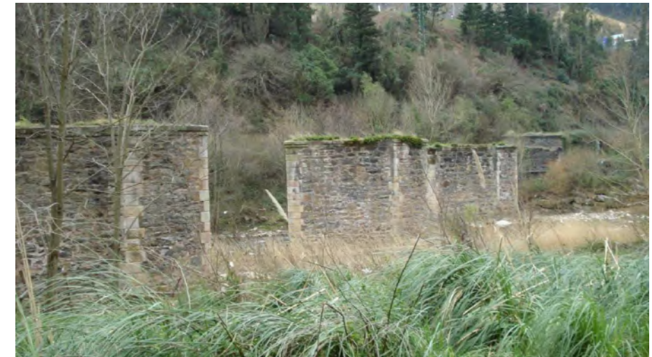
Figura nº16. Pilas existentes del antiguo puente de ferrocarril sobre el río Cadagua
