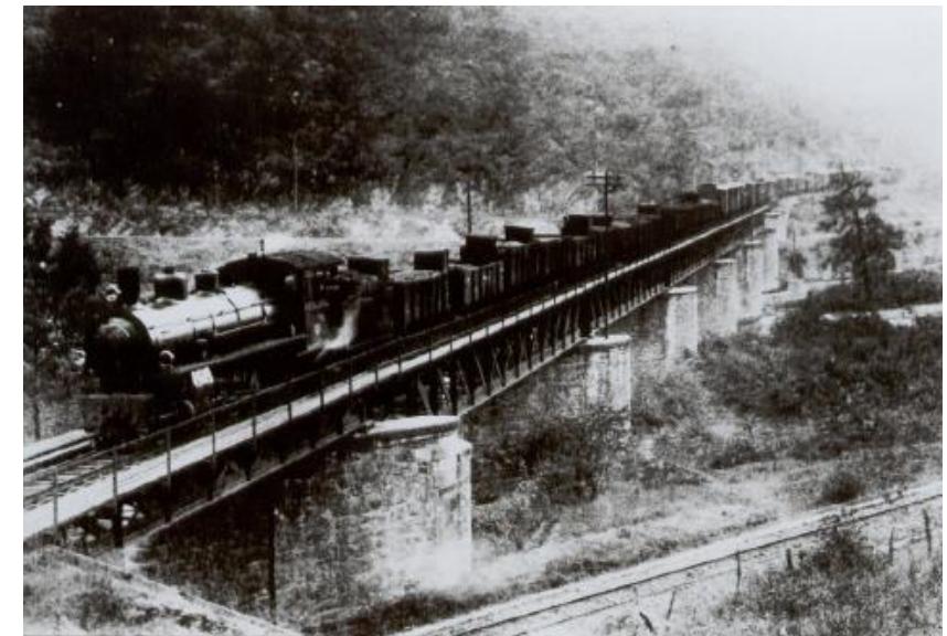
Figura nº11. Vista del antiguo puente.
